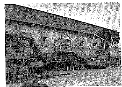
建設廃材なども破砕・選別に より良質な燃料用木くずに
